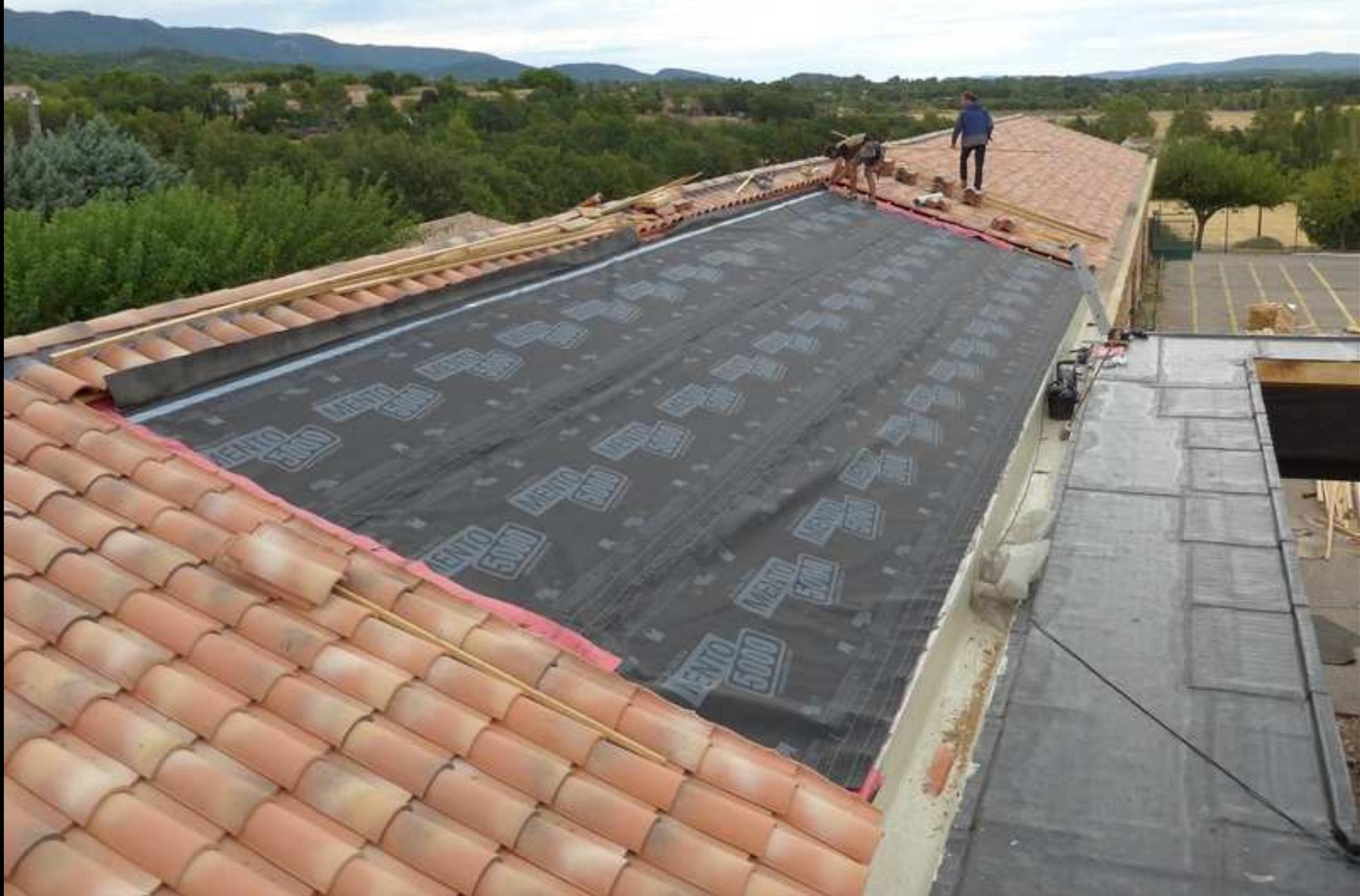
Blocage de l'écran de sous-toiture par des liteaux
