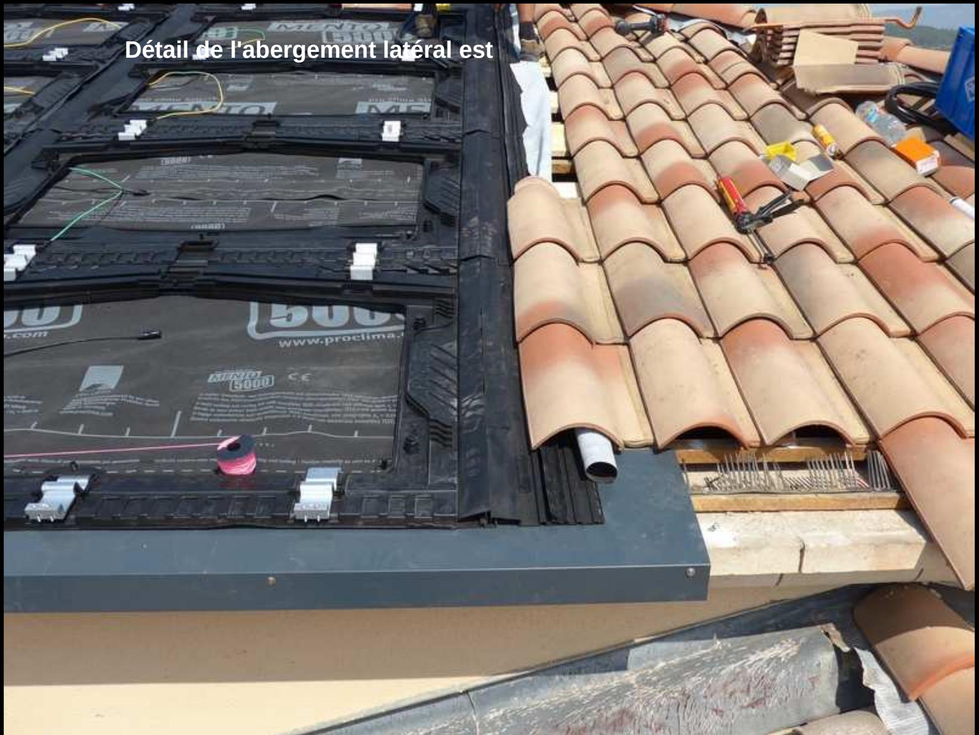
Les tuiles supérieures sont bouchées au polyuréthane
